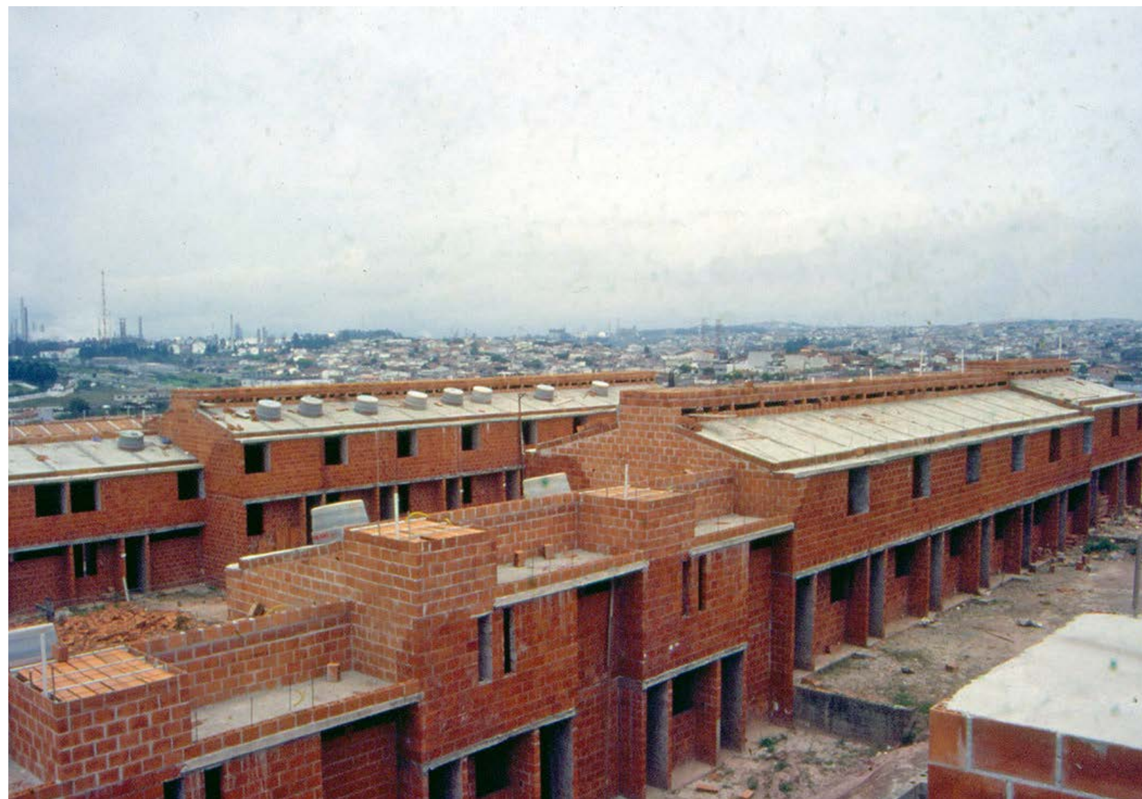
Figura 62 - Realizado com recursos da PMSP através do Programa FUNAPS Comunitário, o Mutirão 26 de Julho foi realizado a partir de 1990 juntamente com a assessoria técnica USINA no bairro de São Mateus, na Zona Leste de São Paulo. Fonte: USINA.
